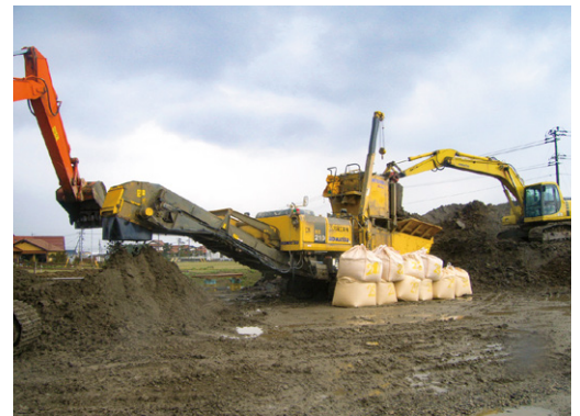
粉体施工:自走式土質改良機
