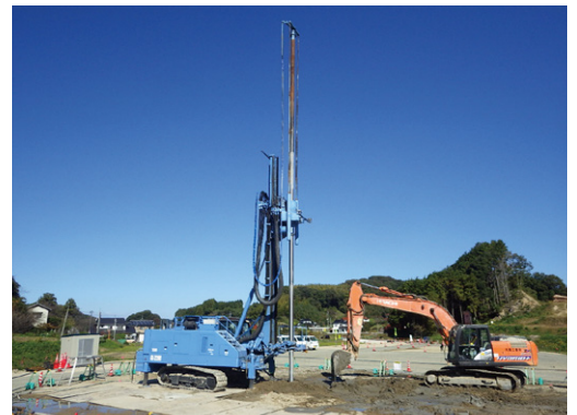
液体施工:中層式混合処理機
